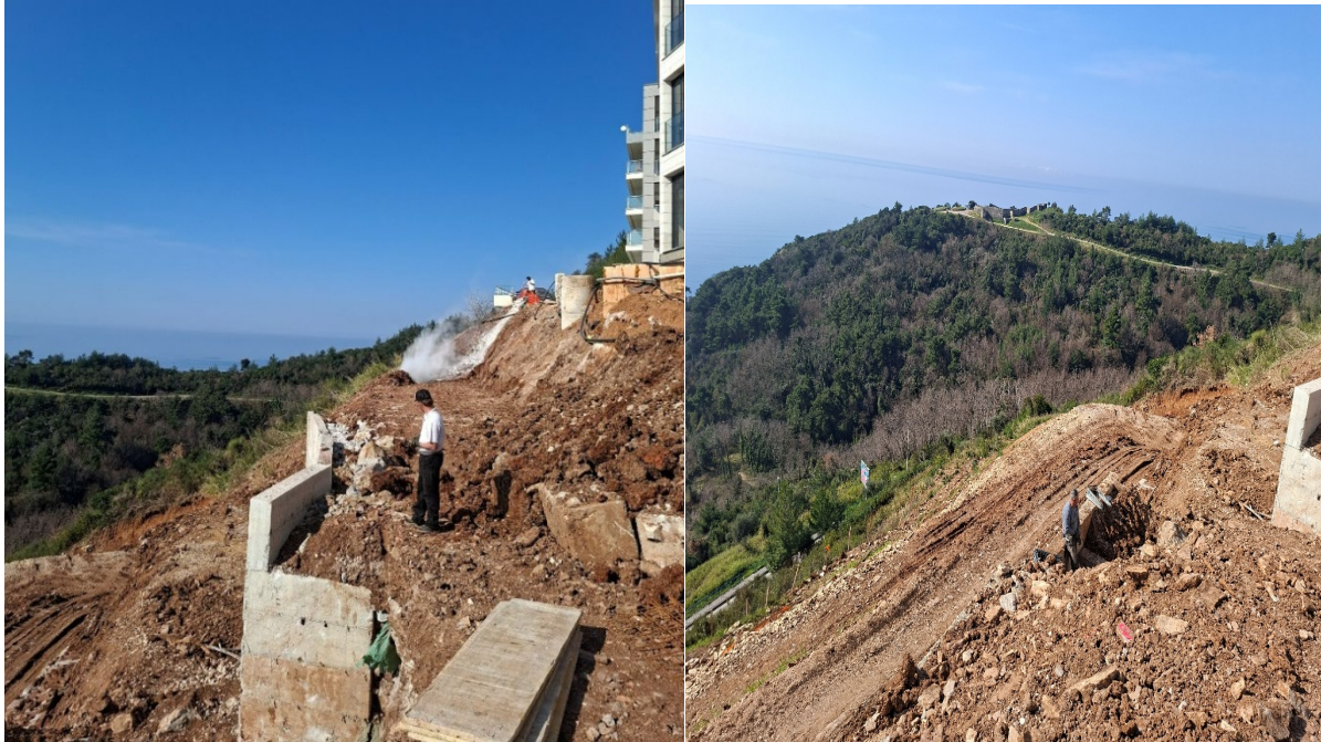
Sl. 8 i 9. Prikaz izvođenja radova na predmetnoj lokaciji Komoševina
