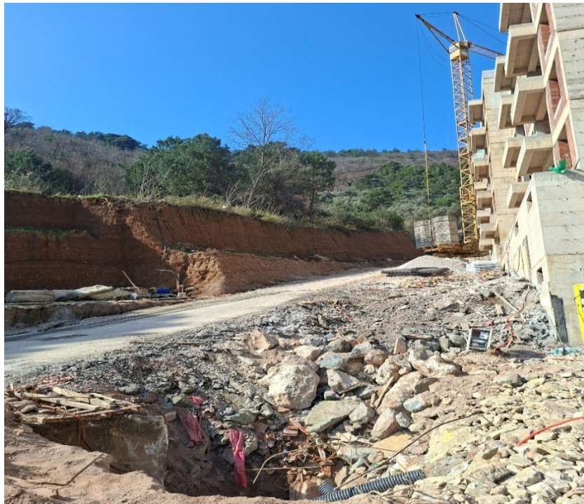
Slika 14. Prikaz gradnje na nestabilnom terenu, koji je dio klizišta
